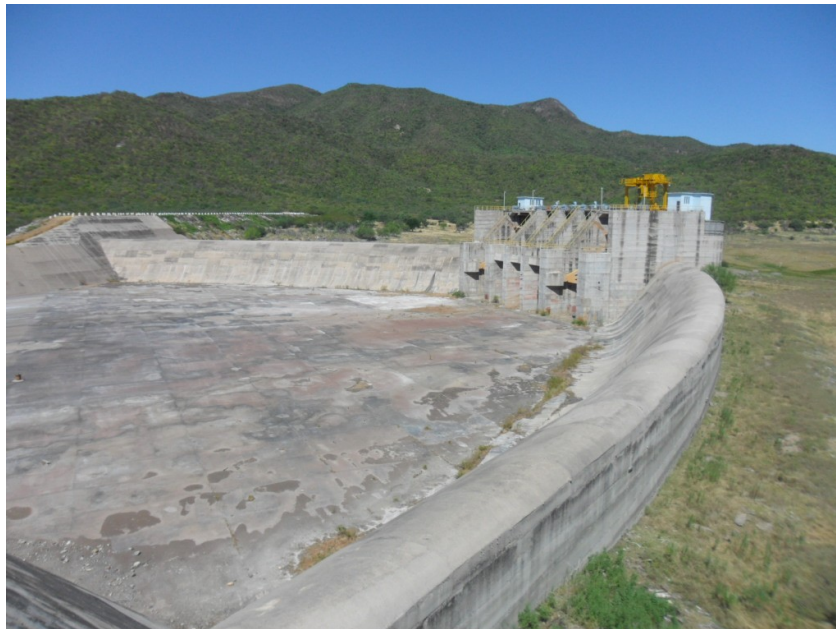
Figura 4.5. Obra de excedencia de la presa Adolfo Ruiz Cortines.
