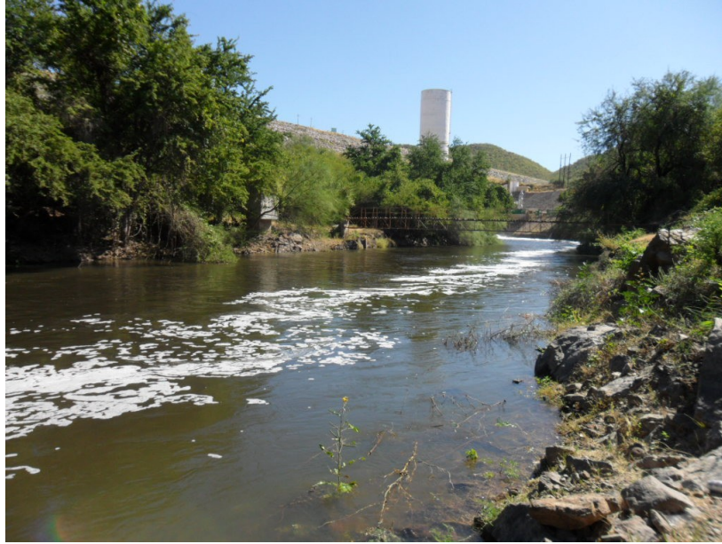
Figura 4.2. Río Mayo, aguas abajo de la presa ARC.
