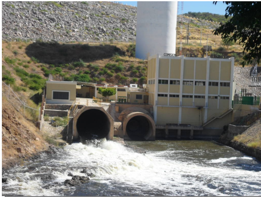
Figura 4.4. Obra de toma de la presa Adolfo Ruiz Cortines.
