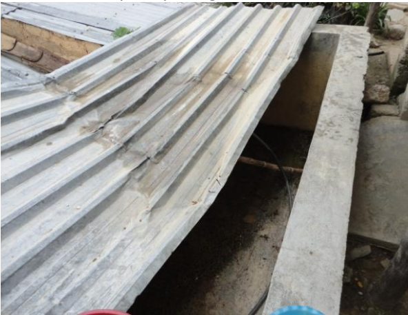
Tanque vacío en estiaje
