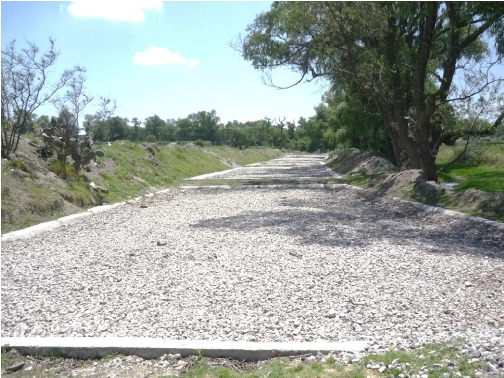
Figura 28. Vista general de las celdas de tratamiento secundario
