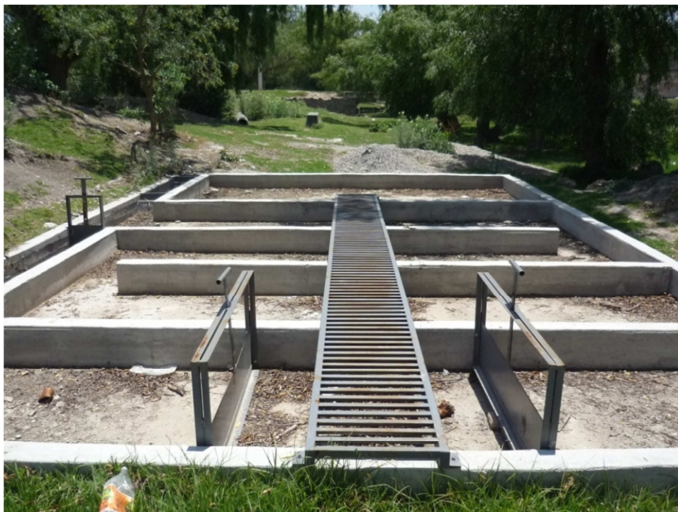
Figura 18. Estructura construida para el pretratamiento
