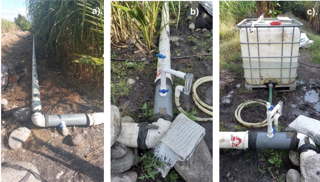
Instalación del inyector Venturi en el sistema de riego de baja presión y multicompuerta, a) vista hacia el hidrante, b) vista hacia las multicompuertas; c) vista del tanque de solución fertilizante de urea.
