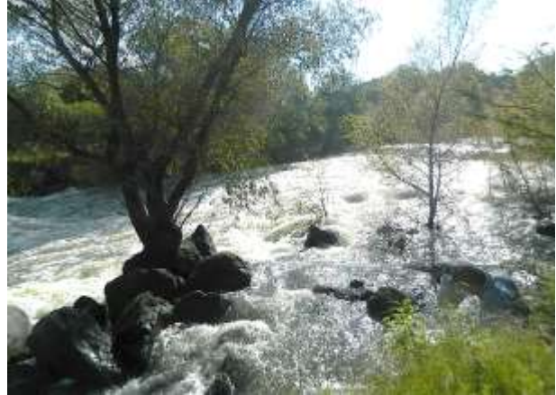
Puerta derivadora de la Presa Solís (septiembre 2018).
