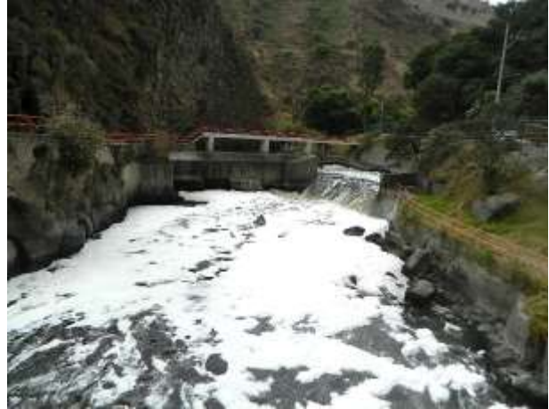
Presa derivadora Temascalcingo (junio 2019).
