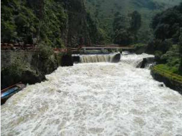
Presa derivadora Temascalcingo (septiembre 2018).
