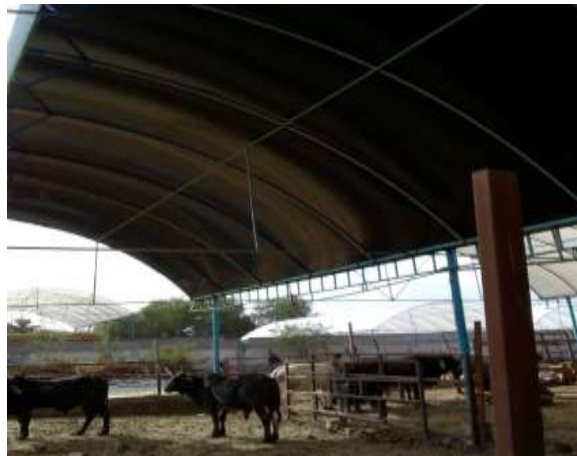
Figura 12. Alternativa adoptada para contrarrestar altas temperaturas dentro en corrales.
