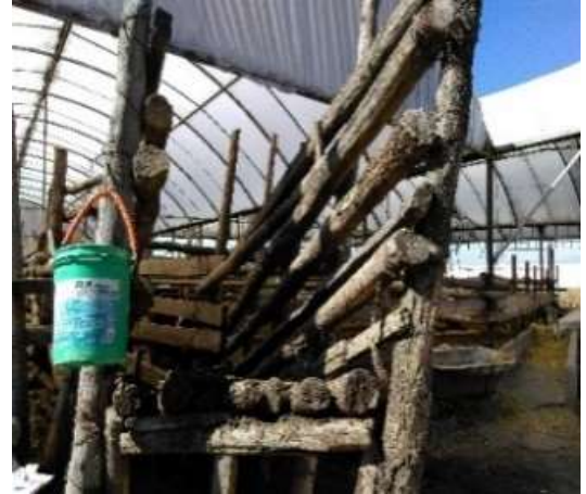
Figura 10. Construcción de rampa con troncos de madera
