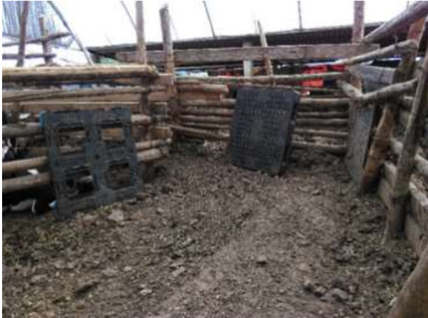
Figura 9. Construcción de corrales con troncos de madera.
