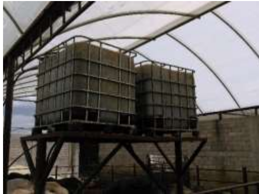
Figura 14. Almacenamiento de agua en depósitos IBC sin lavado frecuente.
