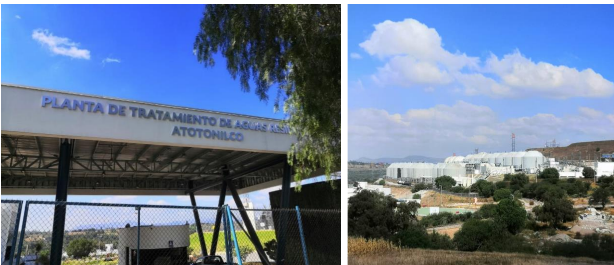
Figura 7.5. Fotos de la PTAR de Atotonilco. Nota: Entrada principal de la PTAR de Atotonilco y sus instalaciones. Elaboración propia.
