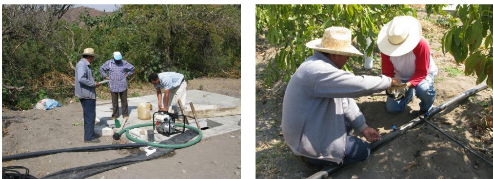
Figura 13. Instalación de cisternas de ferrocemento y sistemas de riego
