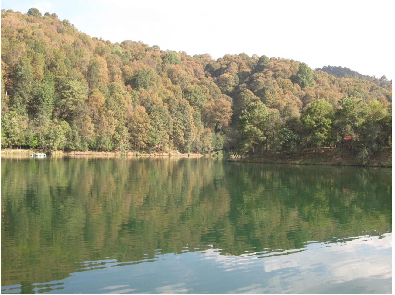
Panorámica general de la presa El Llano.
