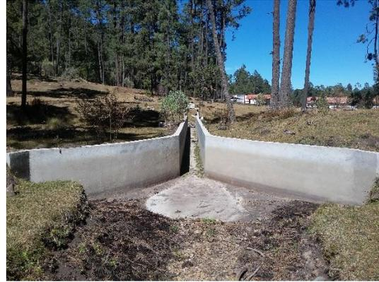
*Figura 3.8. Canal Parshall modificado ubicado en la desembocadura de la microcuenca Zoquiapan.*
