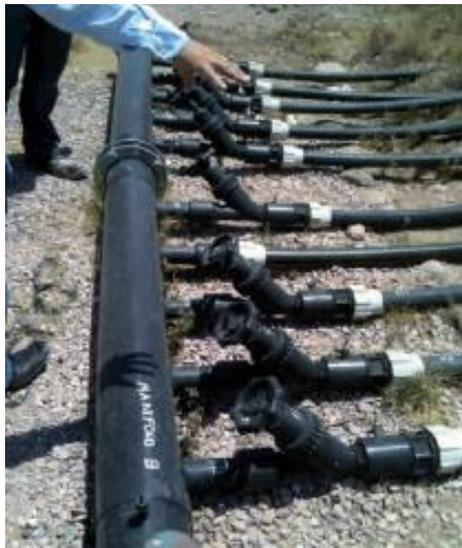
**Figura 19. Cabezal de captación de biogás en relleno sanitario.**
