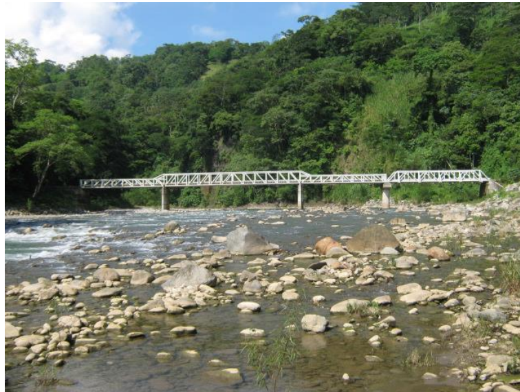
Figura 4-15. Vista aguas arriba de la ubicación de la estación hidrométrica El Refugio A partir de los datos obtenidos en el levantamiento topográfico se obtuvieron las áreas correspondientes a la lectura de escala considerando a su vez la reducción del área provocada por las columnas que sostienen el puente vehicular.
