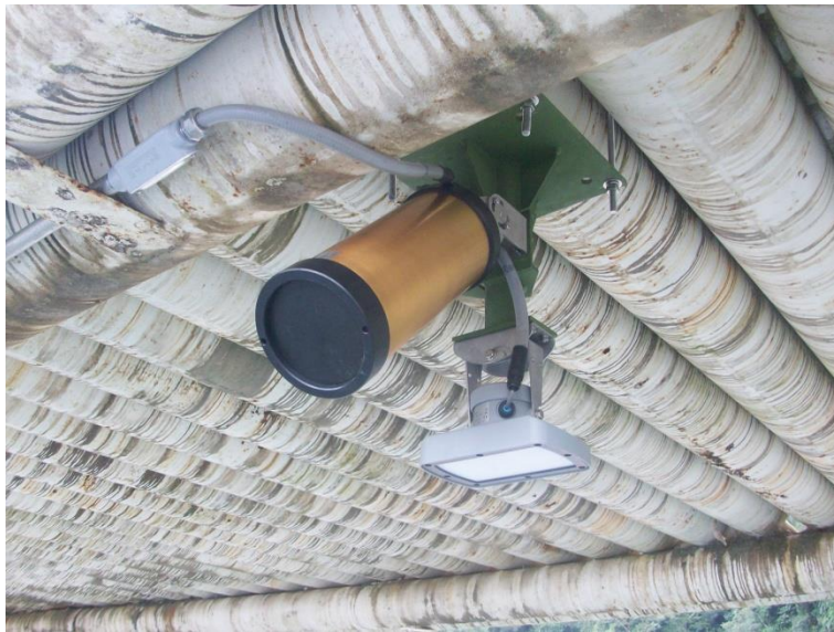
Figura 4-14. Montaje del sensor de radar Kalesto en el puente El Refugio
