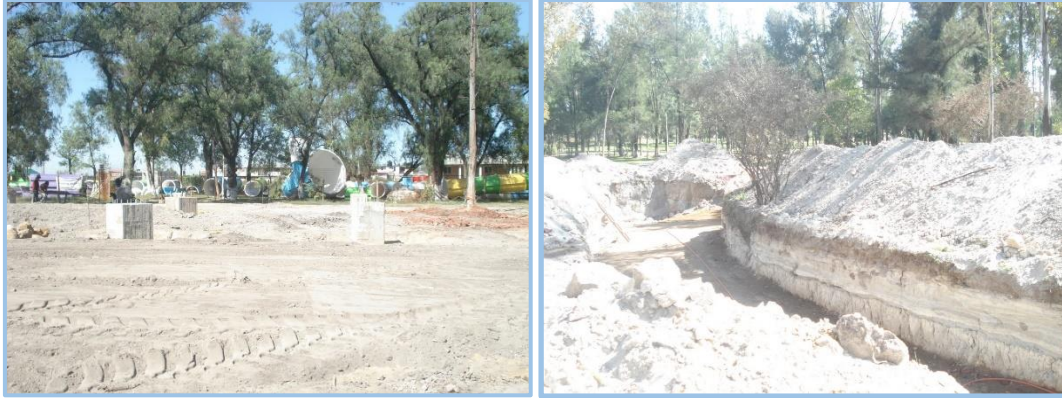
Figura 27. Obras para la remodelación de alberca en el parque del contador, (octubre 2014)
