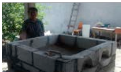
Figura 14 - Estufa con las entradas de leña escarbadas a través del block
