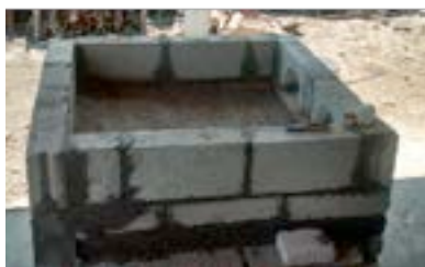
Figura 13 - Base cuadrada de la estufa Lorena mejorada rellena con tierra
