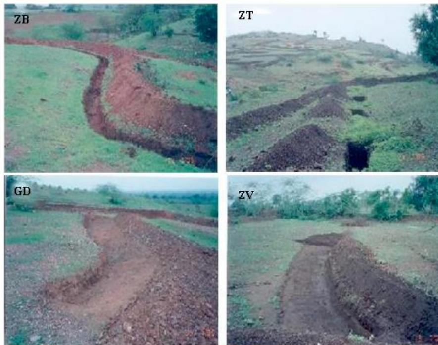
**Figura 5. Prácticas de captación de agua de lluvia o zanjas de infiltración.**
