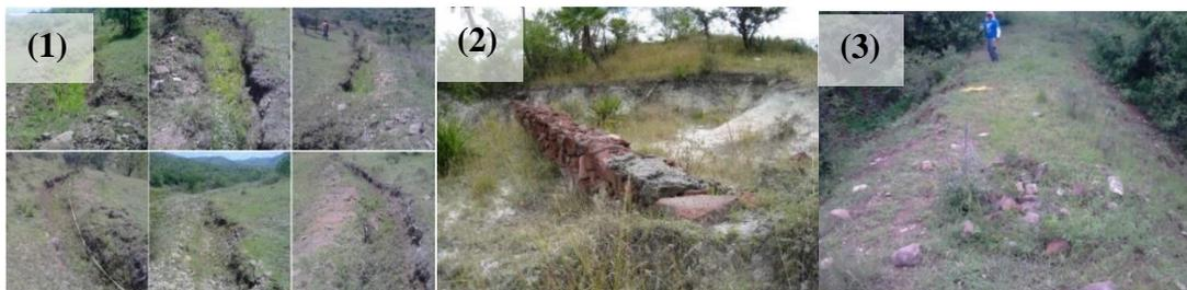
**Figura 26. Zanjas bordo (1), presa filtrante de piedra acomodada (2) y presa de tierra compactada (3).**
