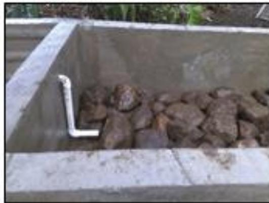
**Figura 27.** Construcción de la trampa de grasas e instalación de tubería.
