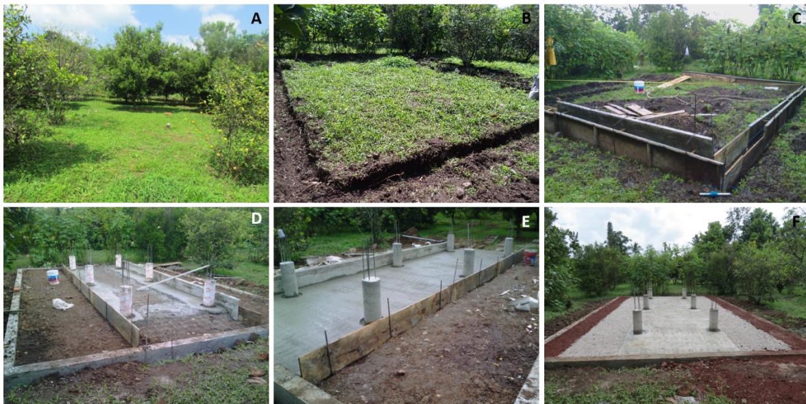
Figura 2.1.7. A: Espacio para la construcción de piso, bosque comestible. B: Preparación de terreno. C: Construcción de límites perimetrales. D: Construcción de postes. E: Construcción de pasillo. F: Piso, postes y límites perimetrales terminados. Foto: H. R. Salazar-Vargas.
