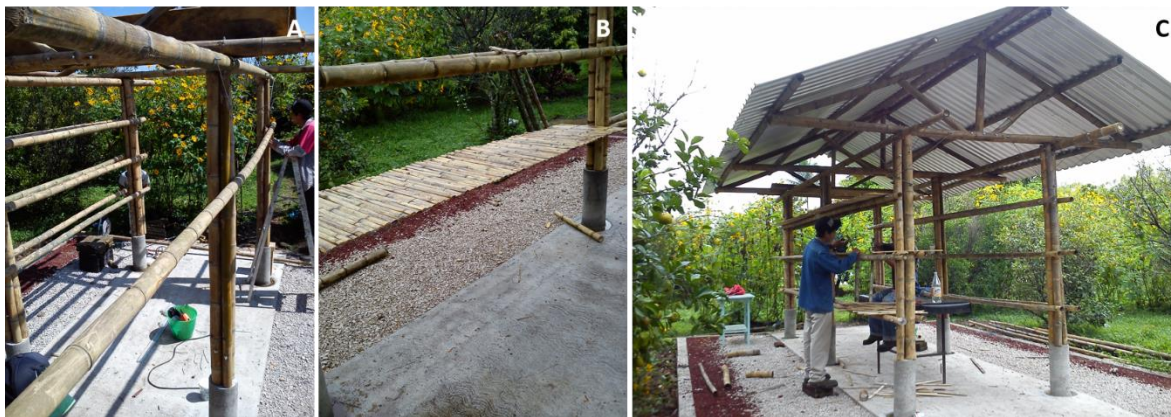
Figura 2.1.9. A: Ensamble de vigas paralelas en columnas. B y C: Ensamble de planchado de bambú para estantes. Foto: H. R. Salazar-Vargas.
