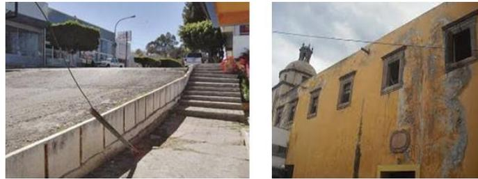
**Figura 3.2 Hundimientos diferenciales y fracturas de Celaya; Gto**
