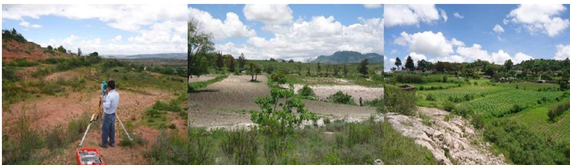
**Figura 27.** Levantamiento topográfico realizado en los sistemas lama-bordo.
