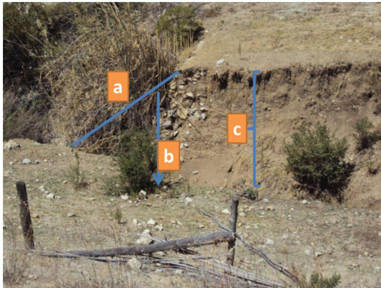
a) bordo construido en la cañada, b) profundidad y c) capa se suelo perdida por falta de mantenimiento del sistema
