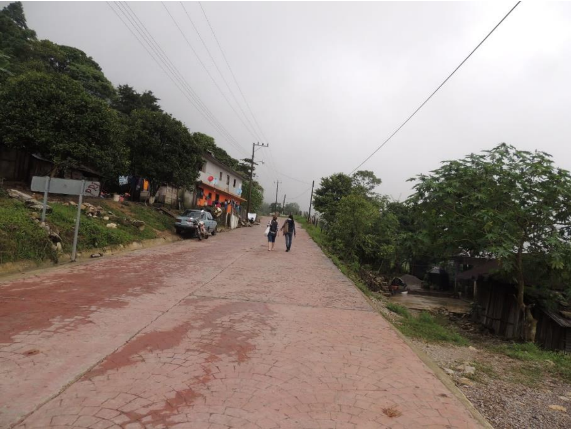
Ilustración 8 Carretera principal de Unión de Guadalupe. Fuente: Elaboración propia, Junio 2015.
