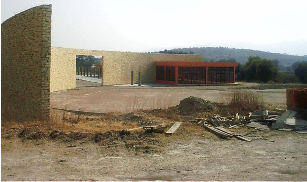
Figura 26. Construcción de explanada del CENTUDE Tarandacua.
