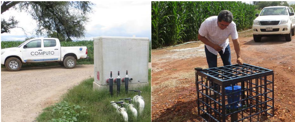
Figura 28. Georreferenciación y memoria fotográfica de la infraestructura construida.
