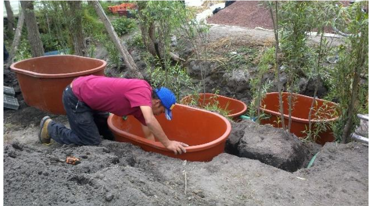
Colocación del sistema y nivelación final de tinas.
