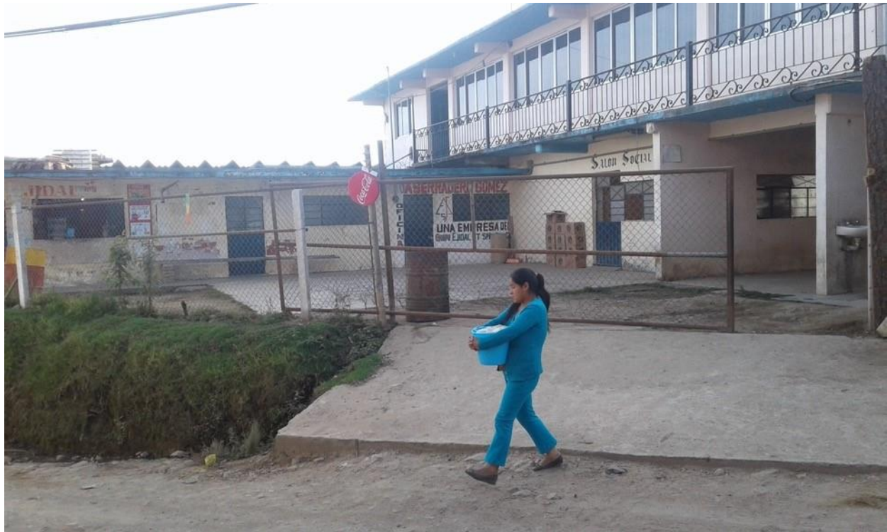
Figura 12. Instalaciones en donde se encuentra el molino ejidal.
