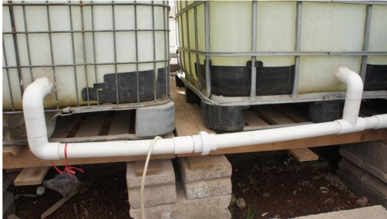
Figura 14. Ubicación del tubo de salida de agua.
