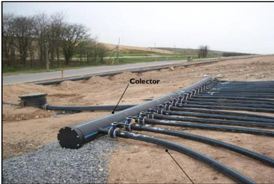
Tuberías laterales provenientes de los pozos de extracción
