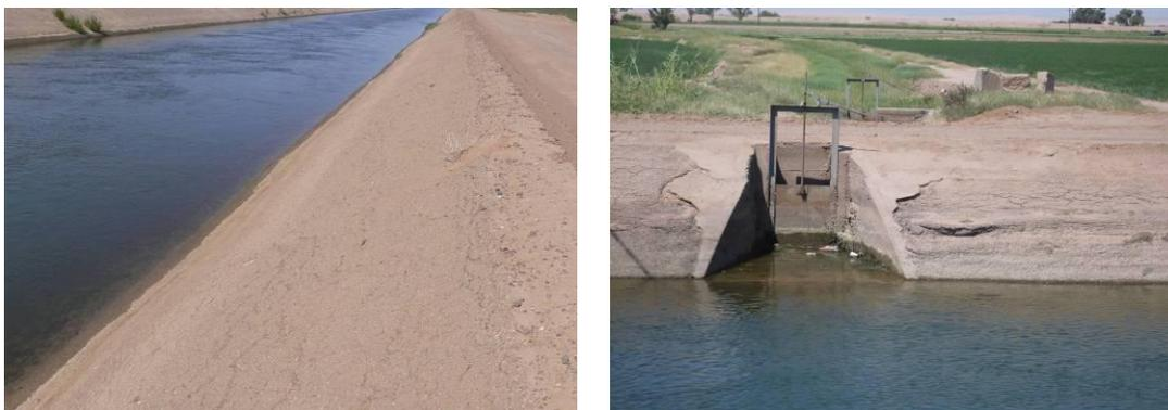
**Figura 6.23. Deterioro del concreto asfáltico en el Canal Independencia**
