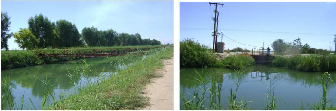
**Figura 6.21. Canal Alimentador del Sur sin revestir del Km 0+880 al Km 5+475**
