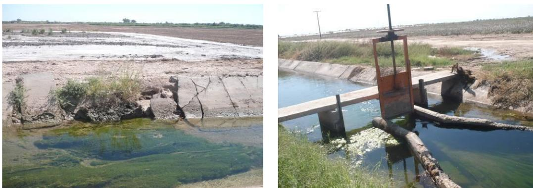
**Figura 6.24. Revestimiento en red menor y reposición de estructuras**
