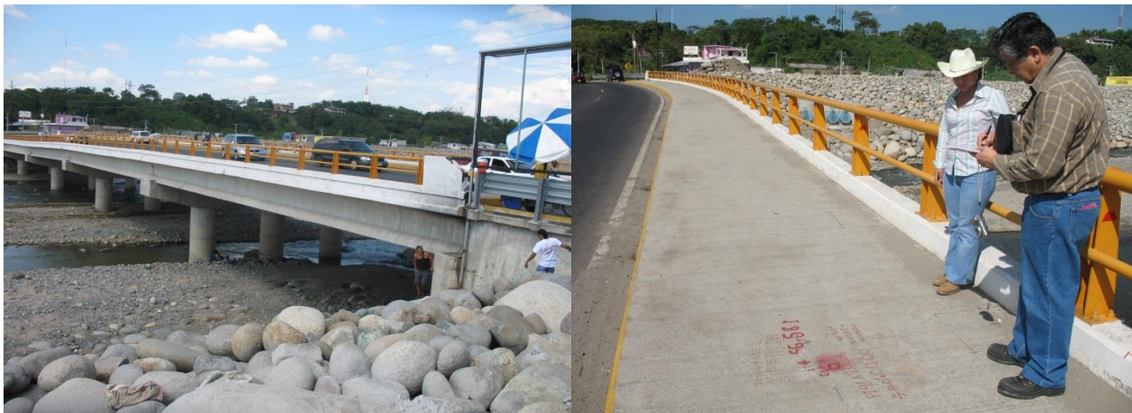
Figura 4.6. Punto de definición de la Cuenca Coatán en el puente de cruce del Río Coatán y la carretera costera a la entrada de la Ciudad de Tapachula
