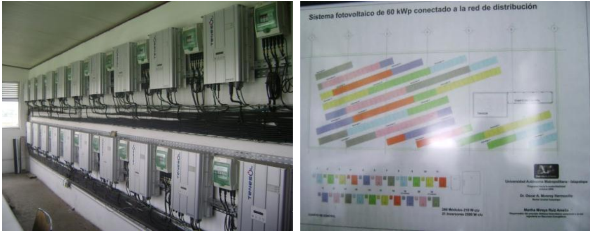
Figura 6.5. Configuración de la instalación de los inversores y módulos fotovoltaicos.
