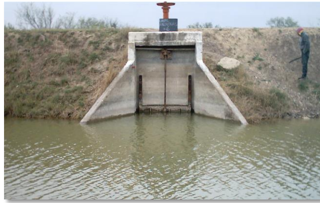
Figura 13. Obra de Toma.
