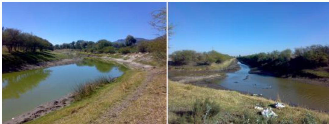
Figura 29. Vista panorámica del dren Munguía y el punto de unión al río Turbio.
