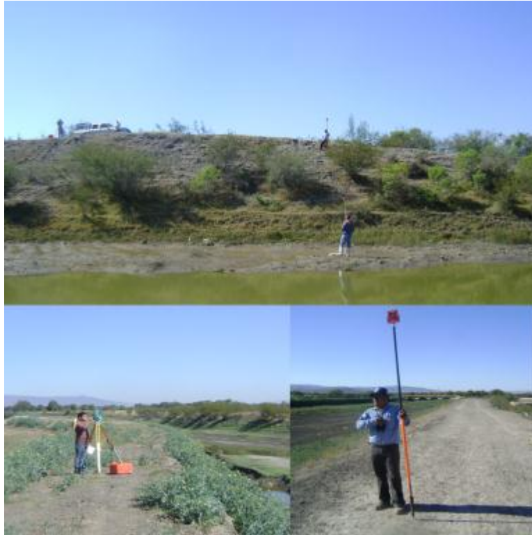
Figura 42. Seccionamiento del cauce del dren Munguía.
