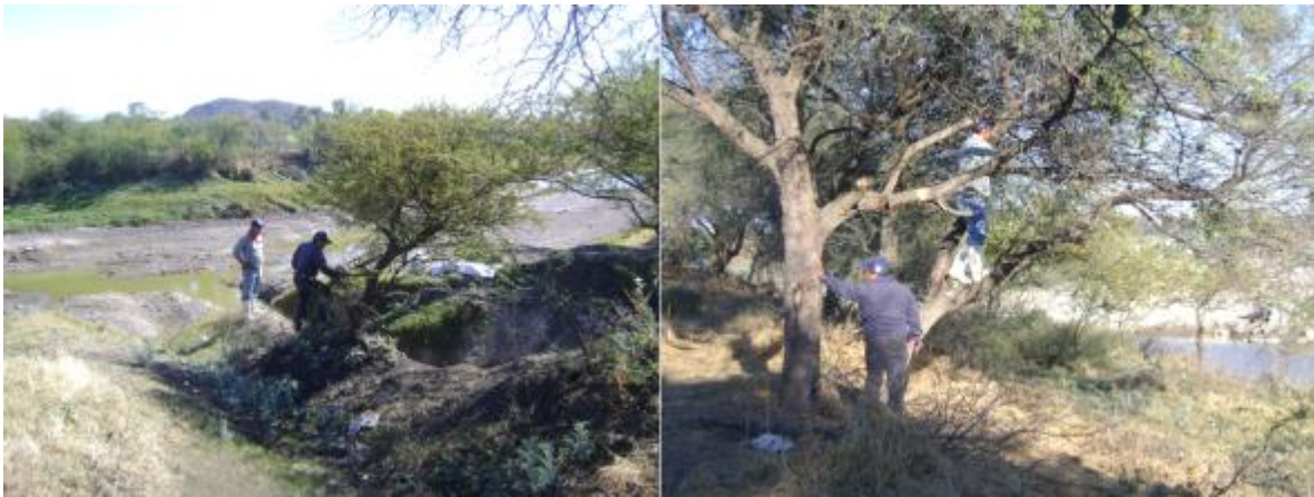
Figura 43. Eliminación de ramas que impedían la visibilidad del prisma
