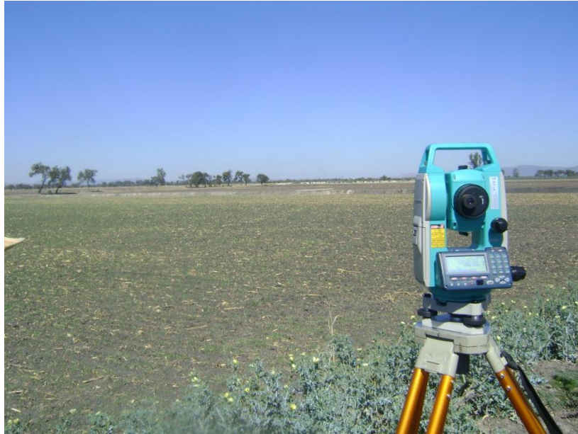
Figura 30. Instalación de estación total.
