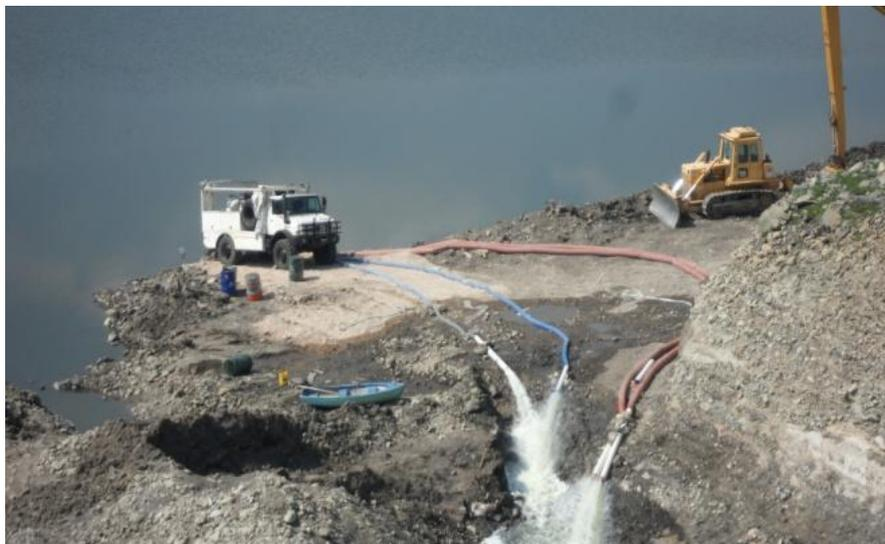
Imagen 14 Bomba sacando agua de la Presa Endhó.
