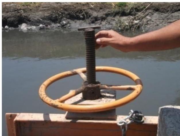
Imagen 7. Roscas de las compuertas que determinan el gasto.
