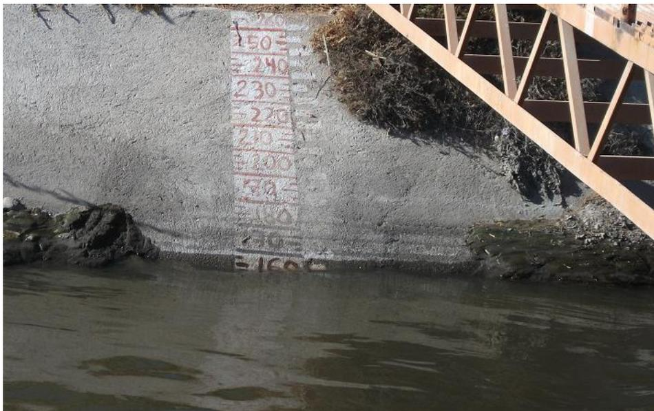
Imagen 5. Escala Gasto de Salida del Canal Endhó.
