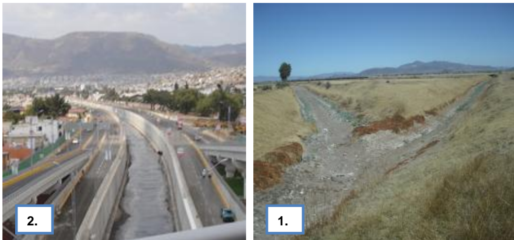
Figura 8. Secciones del cauce del Río de las Avenidas de Pachuca, (A) sección en la ciudad y (B) sección en la planicie
