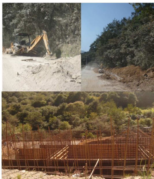
Figura 7.3 Planta de tratamiento en construcción en el municipio de Jilotzingo
