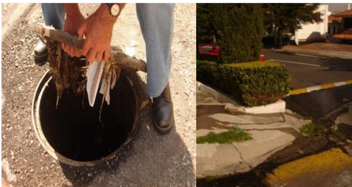
Figura 7.2 Alcantarillado en el Fraccionamiento Chiluca
