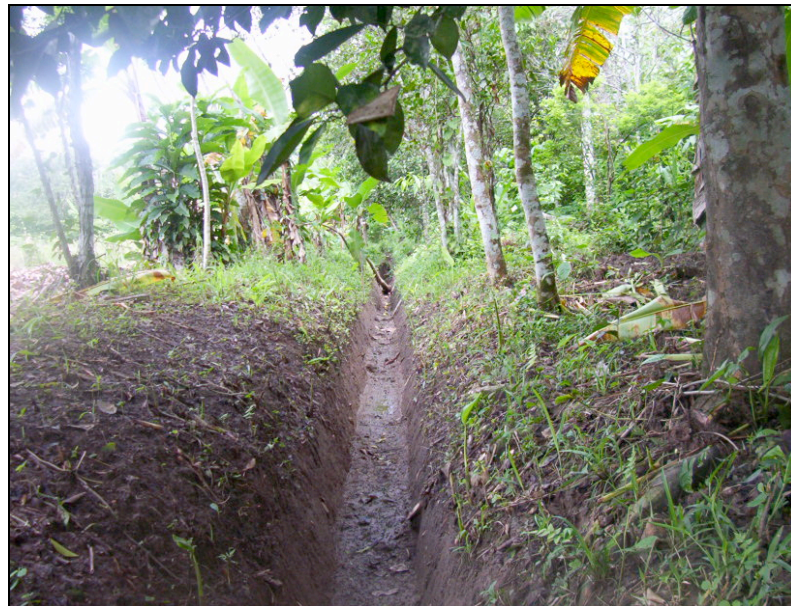
Figura 7. Drenaje parcelario superficial, realizado manualmente en parcelas del Distrito de Temporal Tecnificado 002 Zanapa-Tonalá
