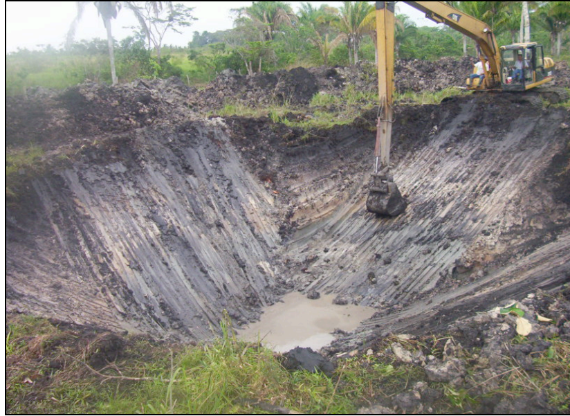
Figura 6. Realización del Jagüey, mediante la maquinaria de la Asociación Civil “La Sabana” del Distrito de Temporal Tecnificado 002 Zanapa-Tonalá.
