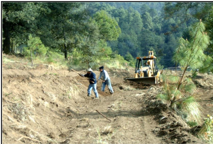
Figura 4.8. Retroexcavadora realizando movimientos de suelo para formar las terrazas de banco en Rancho Jesús María.
