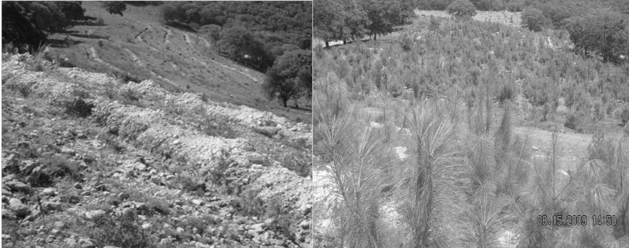
Fotografía 3. Zanjas trincheras para la captación de agua pluvial
