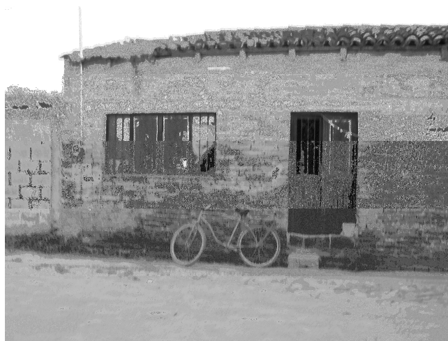
Figura 7. Aspecto general de las viviendas del DTT.
