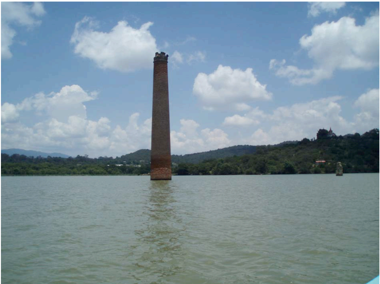
Figura 6.8 Presa San Antonio Regla, Huasca de Ocampo, Hidalgo
