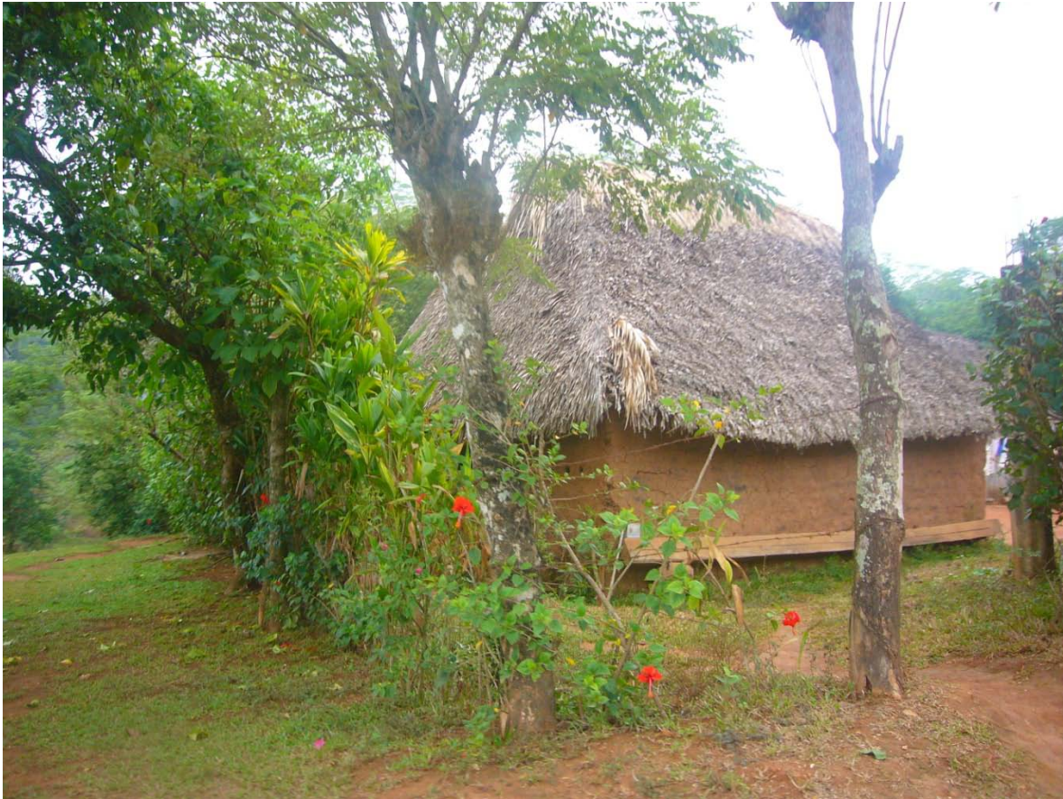
Figura A10.Casa tradicional de paredes de embarre y techo de palma. Ejido Macayal.
