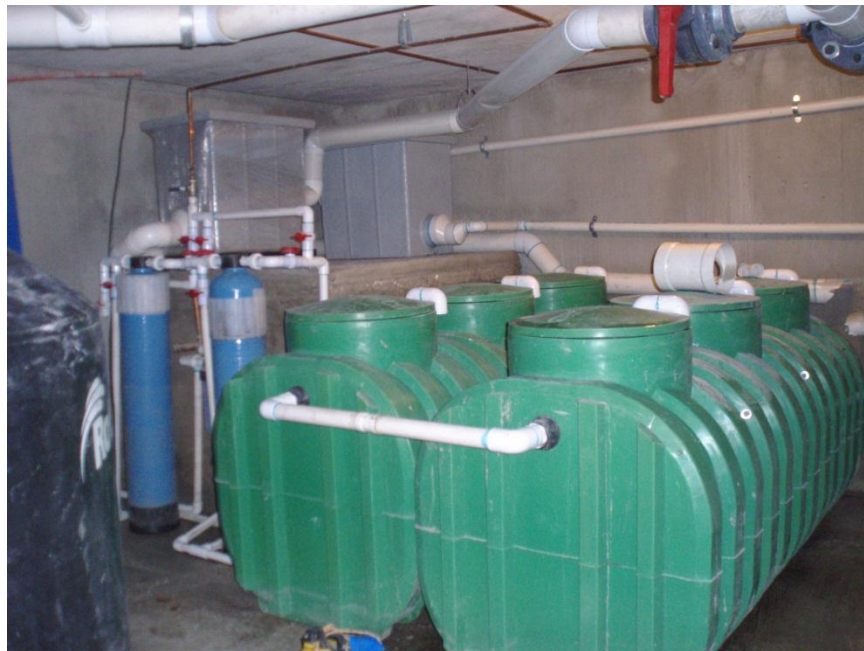
Figura 5.15 Microplanta de 750 litros por día.
