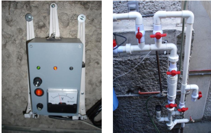
Figura 5.33 Vista del control de la celda iónica
