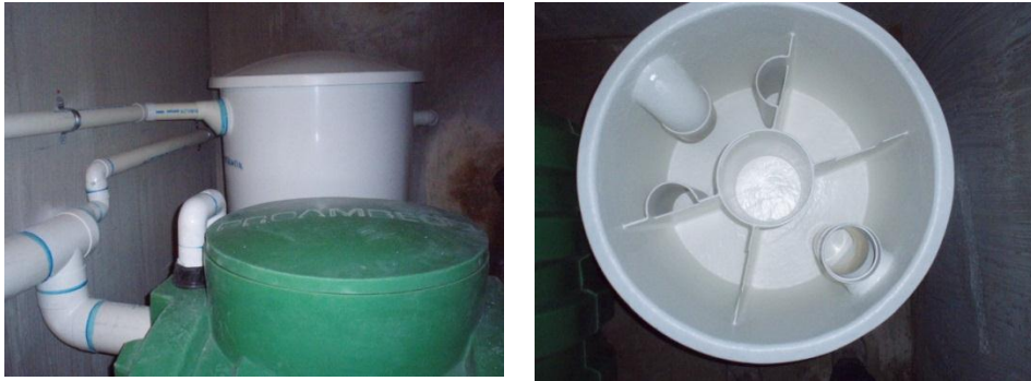
Figura 5.14 Trampa de grasas de 80 litros de capacidad.
