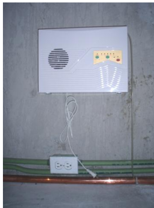
Figura 5.19 Equipo generador de ozono a través del aire.
