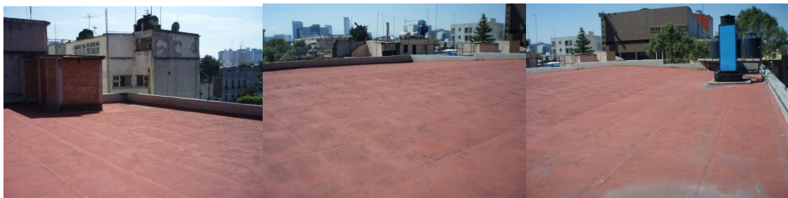
Figura 5.24 Vista del área de captación.
