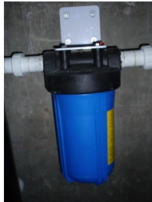
Figura 5.22 Porta filtro BB10x4" con cartucho plisado de 10 micras.
