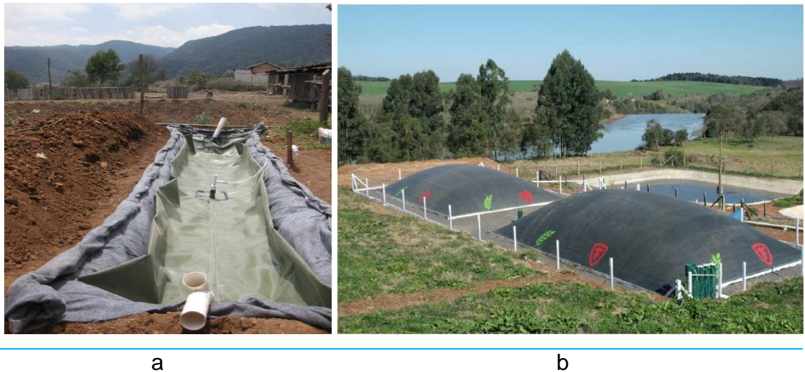
Figura 2.21 Biodigestor de geomembrana, (a) doméstico y (b) industrial (Aqualimpia, 2009).
