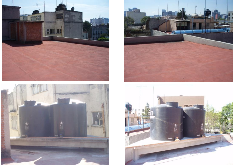
Figura 5.34 Bases de concreto y tinacos instalados en lado este (izquierda) y lado oeste (derecha).
