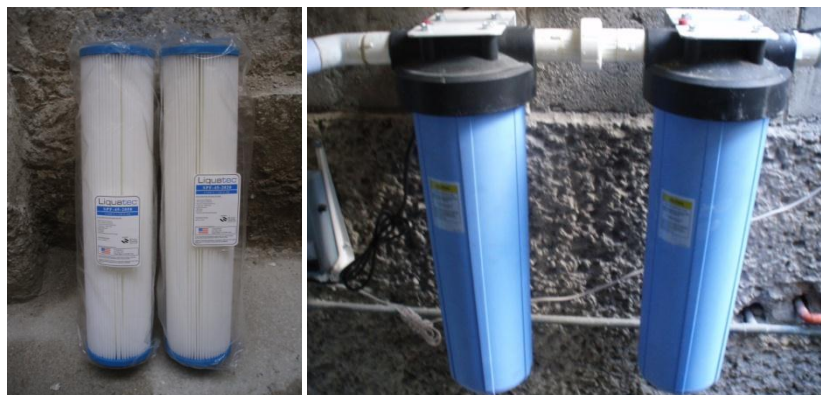
Figura 5.32 Vista de cartuchos plisados de 50 y 20 micras (izquierda) y los 2 portafiltros BB20" Azul (derecha).
