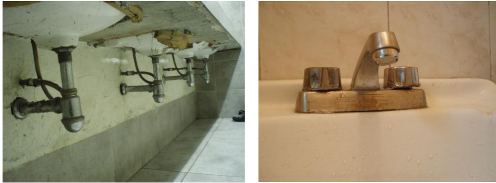
Figura 5.36 Ahorradores en línea y en lavabo de 6 litros por minuto certificados por Centro de Normalización y Certificación de Productos (CNCP) Organismo Nacional en México.
