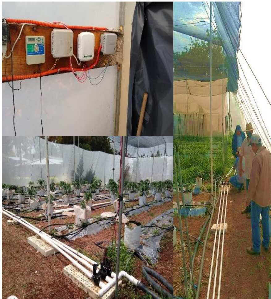
Figura 5. Instalación del sistema de riego y temporizador.
