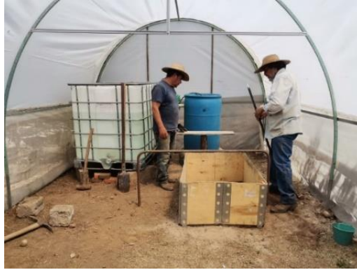
b. Construcción del tanque sumidero y cultivo de sustrato
