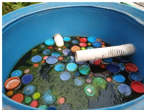
Figura 55 Crecimiento de algas en el biofiltro, originado por el estancamiento del agua. Fuente: Propia.
