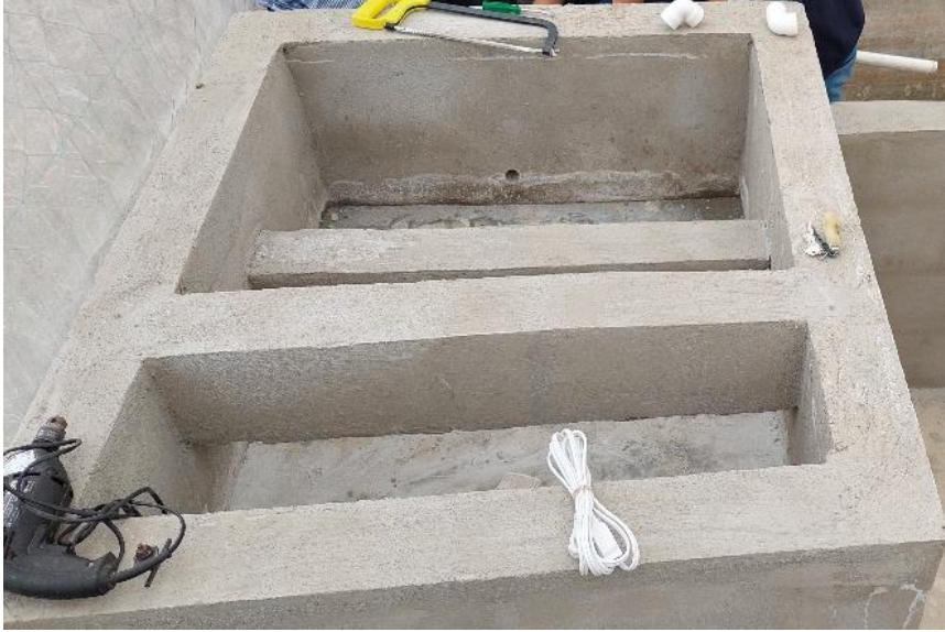
Figura 38. Trampa de grasa construcción
