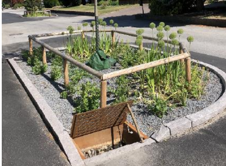
Figura 3. Biofiltro municipal de agua pluvial en Suecia (Sitio 1)
