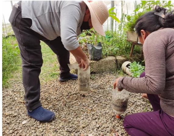
Figura 33. Elaboración de un filtro de arena. A corte de botellas de plástico y B llenado de las capas.
