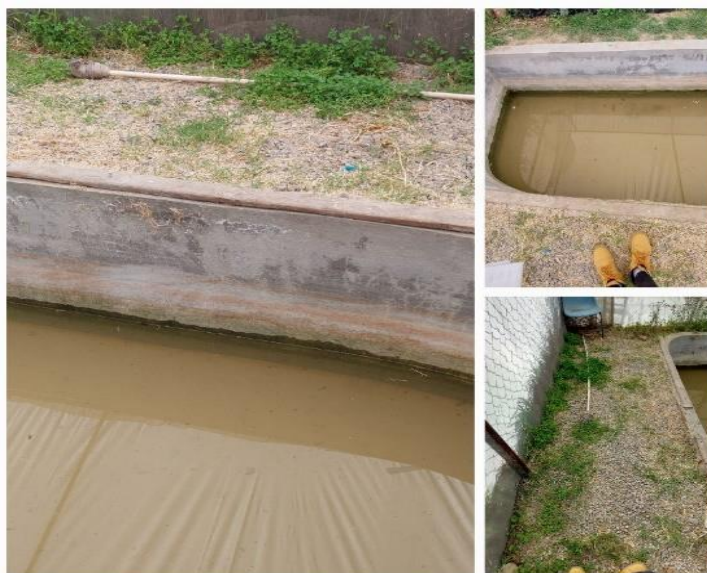
Figura 36. Área para la instalación del tren de tratamiento FITOECOFIL
