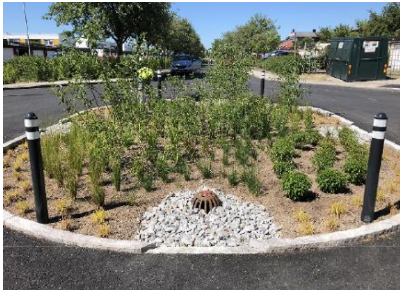
Figura 4. Biofiltro municipal de agua pluvial en Suecia (sitio 3)
