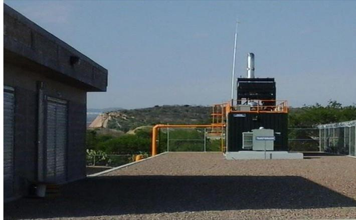
Figura 9. Moto generador de energía
