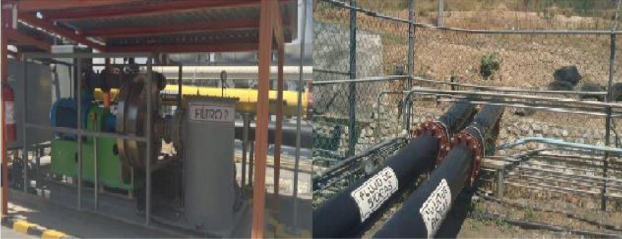
Figura 14. Conducción y fitro de biogás.
