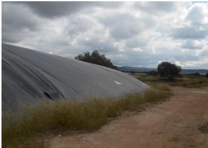
Figura 4. Geomembrana de captura de biogás.
