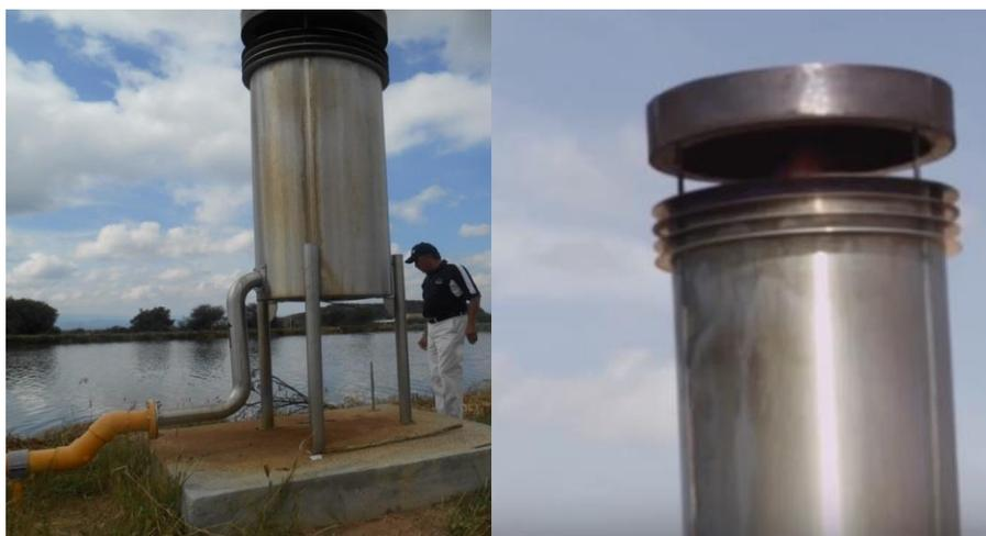
Figura 6. Quemador de la planta de biogás en “PolloQro”
