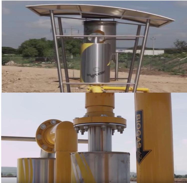
Figura 5. Módulo de medición y filtrado de biogás.
