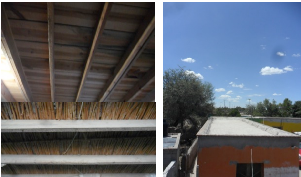
Figura 20. Vista del interior y exterior del techo de una casa típica del medio rural de la Comarca Lagunera.
