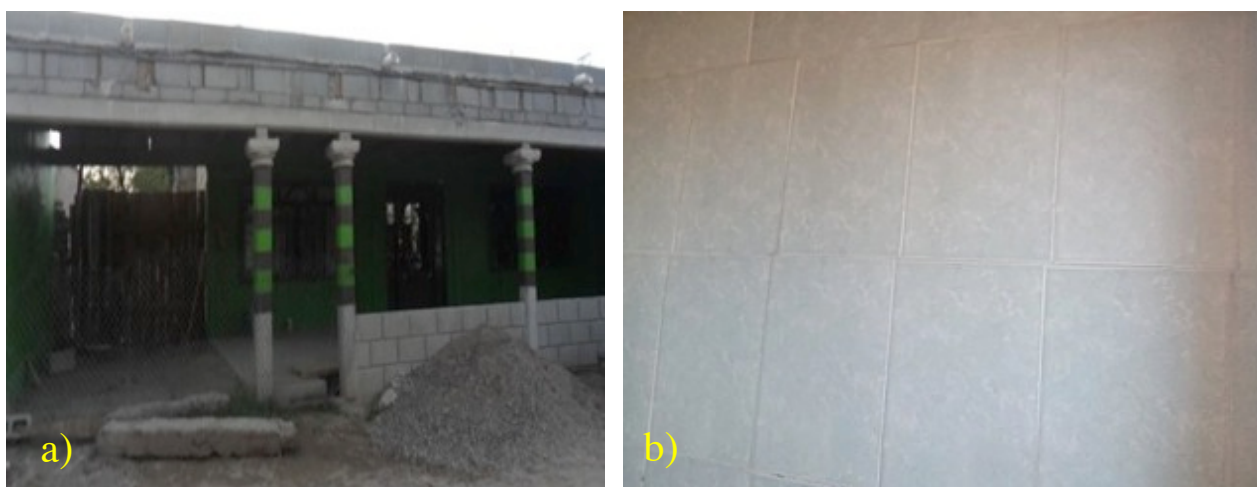
Figura 34. a) Vivienda rural construida siguiendo completamente el diseño de la casa en la que los dueños habitaron durante su estancia en la ciudad, b) Pared de un baño rural recubierta con mosaico cerámico disparejo y desnivelado.
