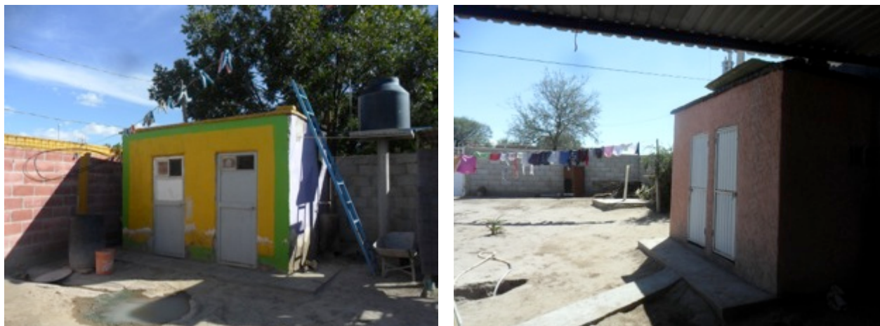
Figura 19. Baños de casas que comparten áreas en común, puede apreciarse que el sanitario está separado de la regadera.
