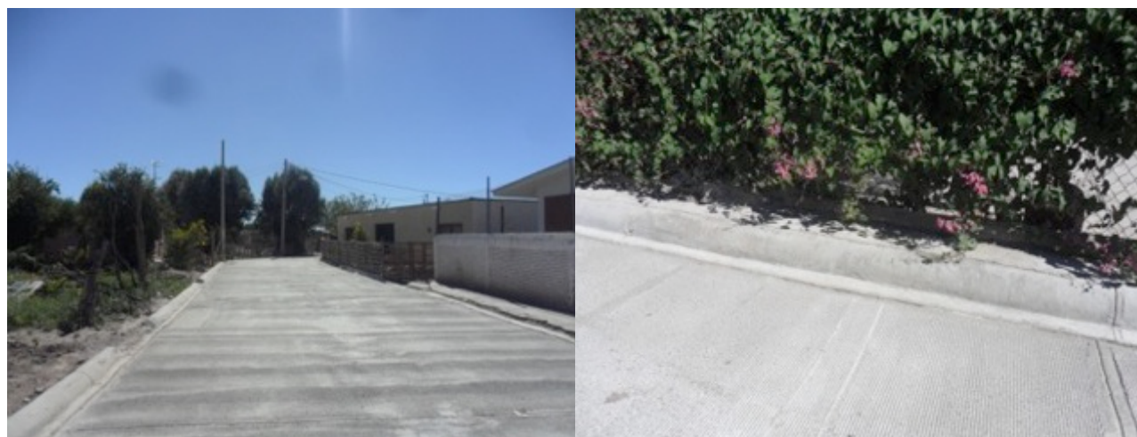
Figura 28. Calles encarpetadas con concreto hidráulico en Colón, Francisco I. Madero, Coahuila.
