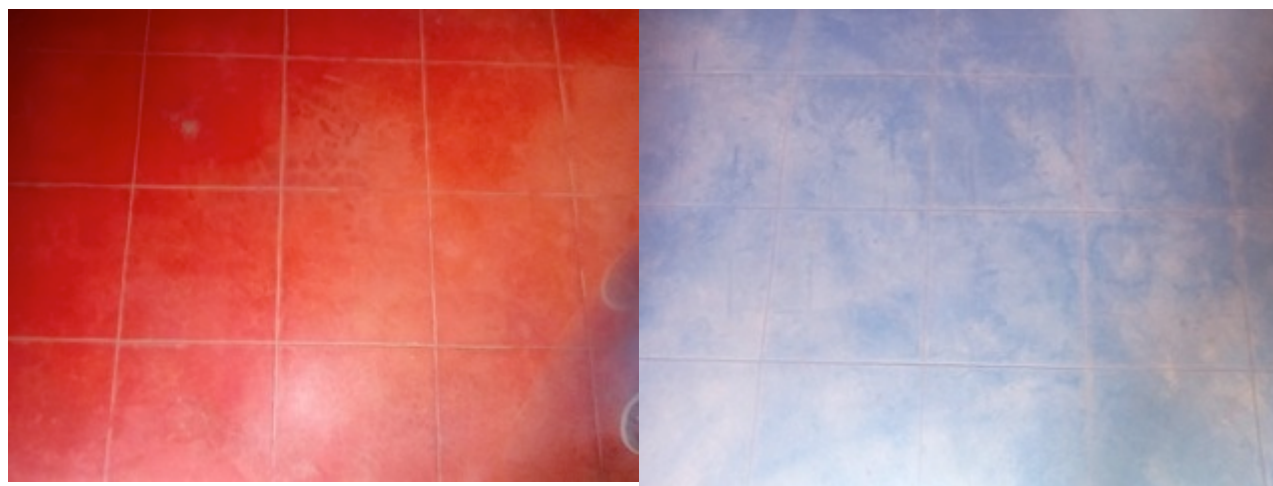
Figura 23. Pisos de cemento pintado con pintura vinílica.
