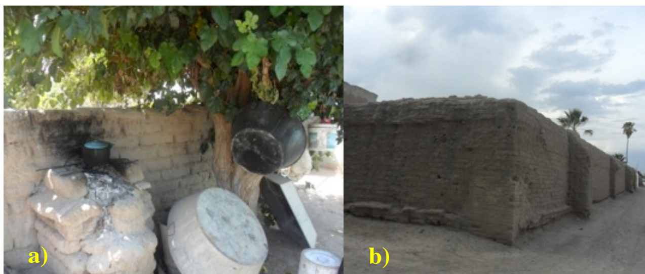
Figura 26. a) Barda de adobe de una casa campesina de hace 100 años, b) Barda de adobe de la casona de una ex-hacienda algodonera.
