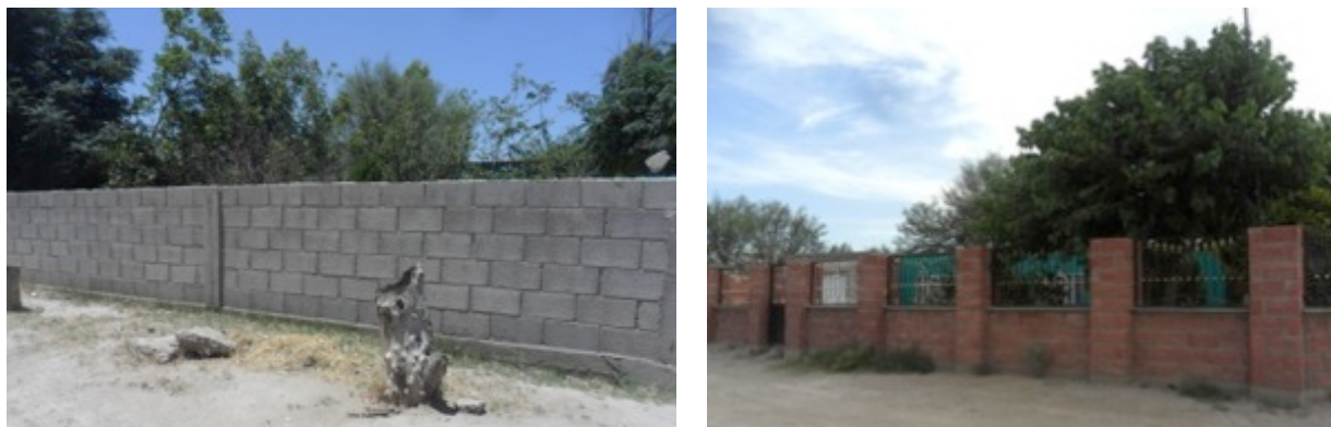
Figura 25. Ejemplos de bardas de block y tabicón de las viviendas rurales de la Comarca Lagunera.
