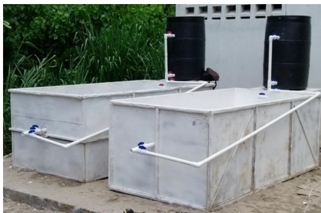
Figura 8. Tanques receptores de aguas residuales provenientes de los sanitarios de la División Académica de Ciencias Biológicas
