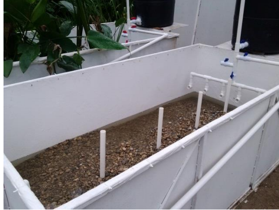
Figura 10. Instalación del humedal artificial de flujo subsuperficial en la División Académica de Ciencias Biológicas
