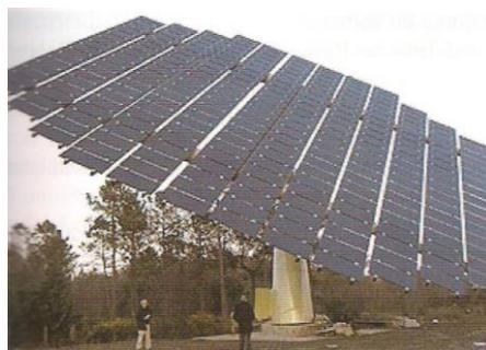
Figura 8. Seguidor solar hidráulico instalado en Vilalba (Lugo), con una superficie portapaneles de 345 m<sup>2</sup> y una potencia de 42 kW
