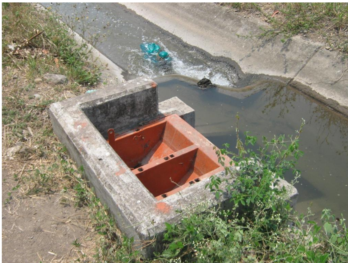
Figura 3.6 Fotografía de una estructura de gasto constante tipo XX_2 con vertedor en forma de Z
