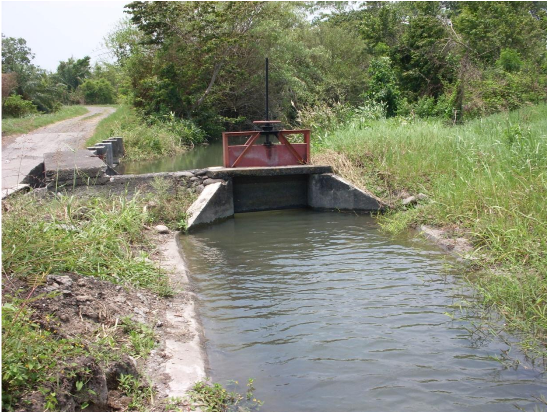
Figura 3.5 Fotografía de la presa derivadora y canal Principal Cedro II del módulo II-1 Actopan
