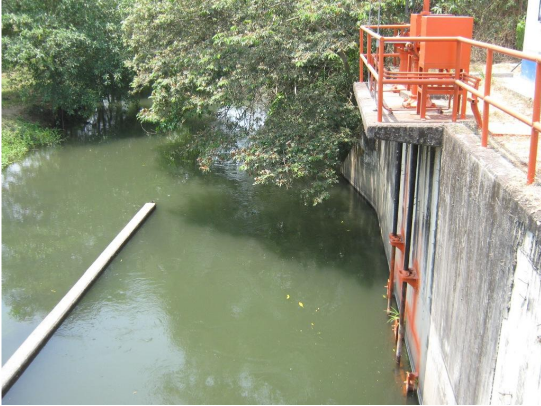
Figura 3.4 Fotografía de la presa derivadora Carrizal
