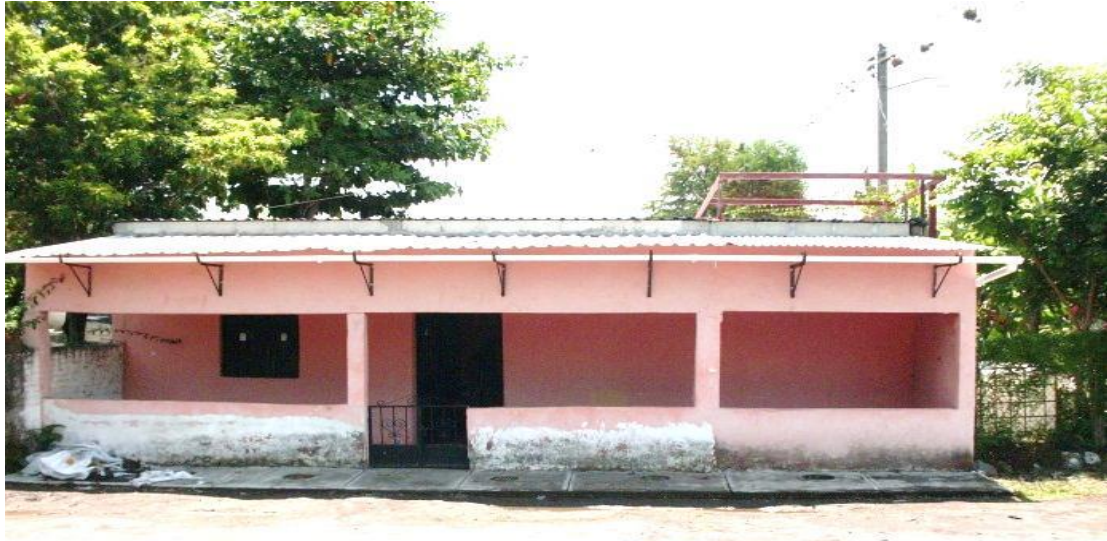
Figura 4. Sistema de captación de agua de lluvia demostrativo
