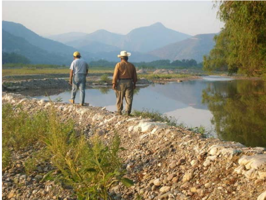
Figura 7. Muestra de una bocatoma en Alpoyeca, Gro.
